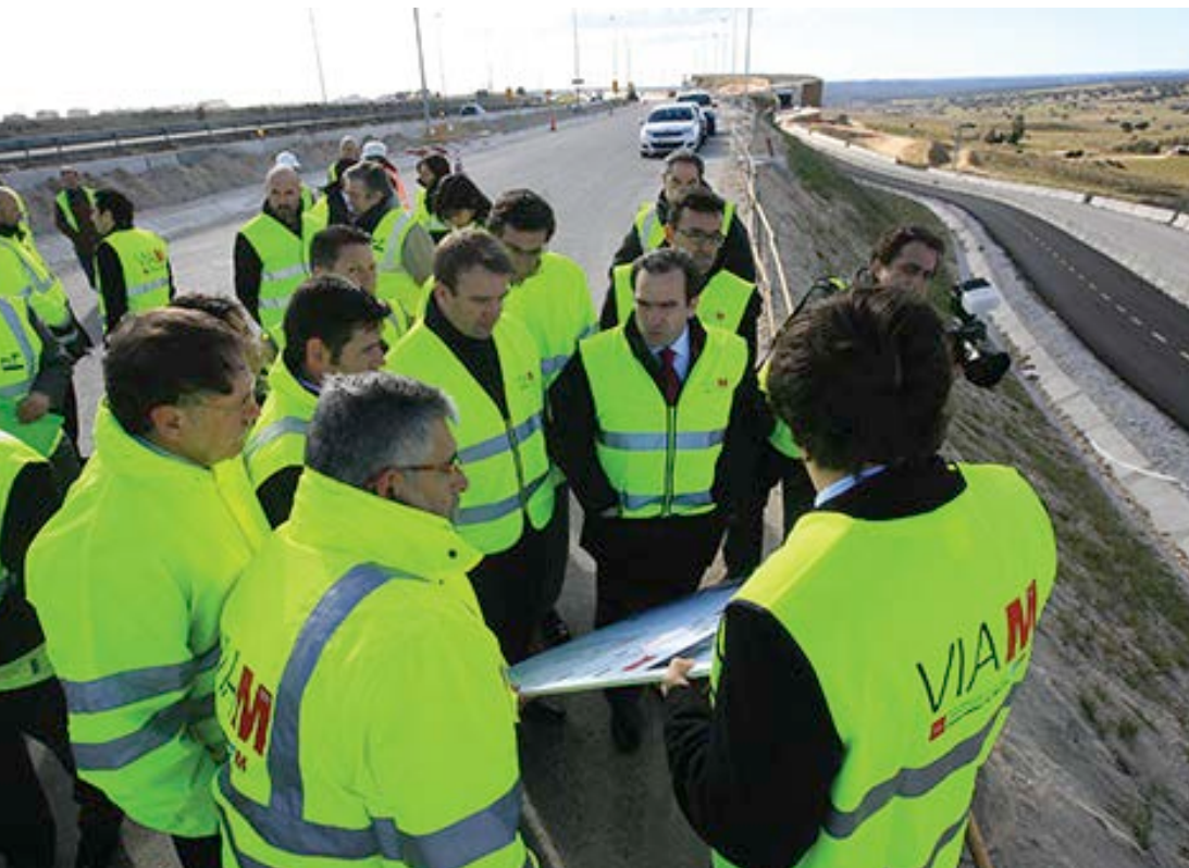
Los directivos de FCC detallan a las autoridades los avances de las obras.
